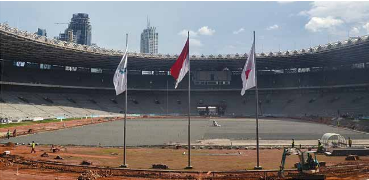
Stadion Utama Gelora Bung Karno dalam tahap renovasi
