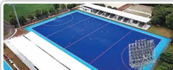
Lapangan Hoki setelah renovasi
